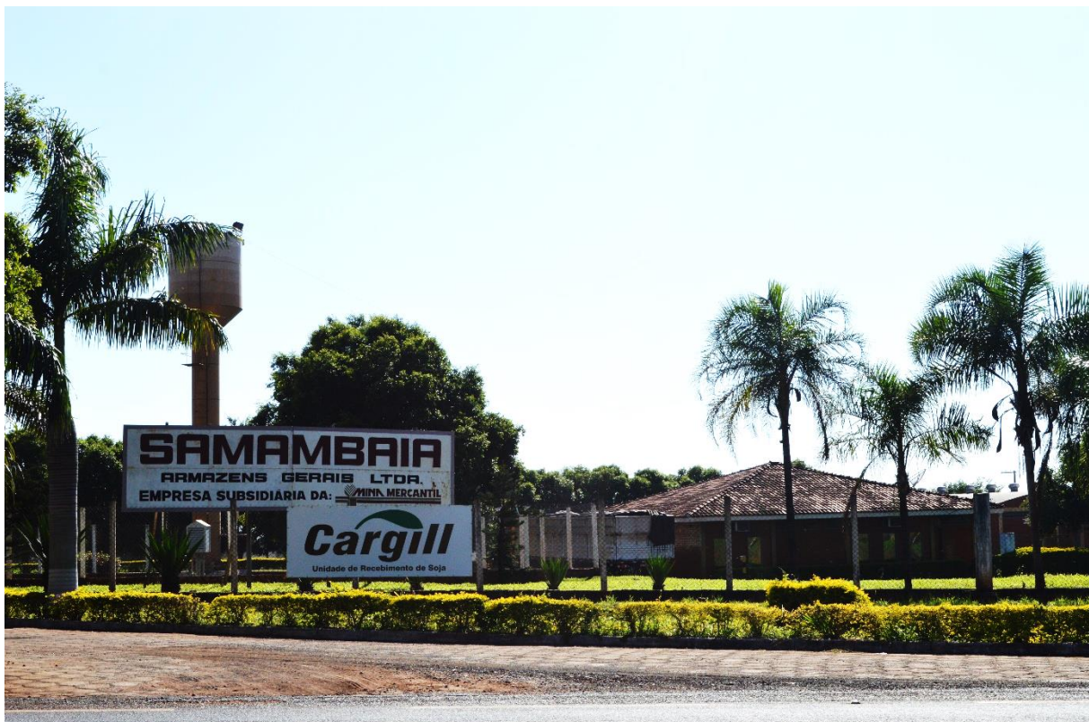
Figura 44: Armazém da Samambaia em Riolândia – Fonte PMR
