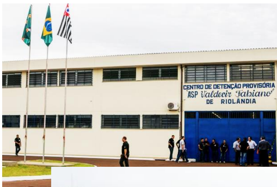
Figura 48: CDP Riolândia entrada Fonte PMR.
