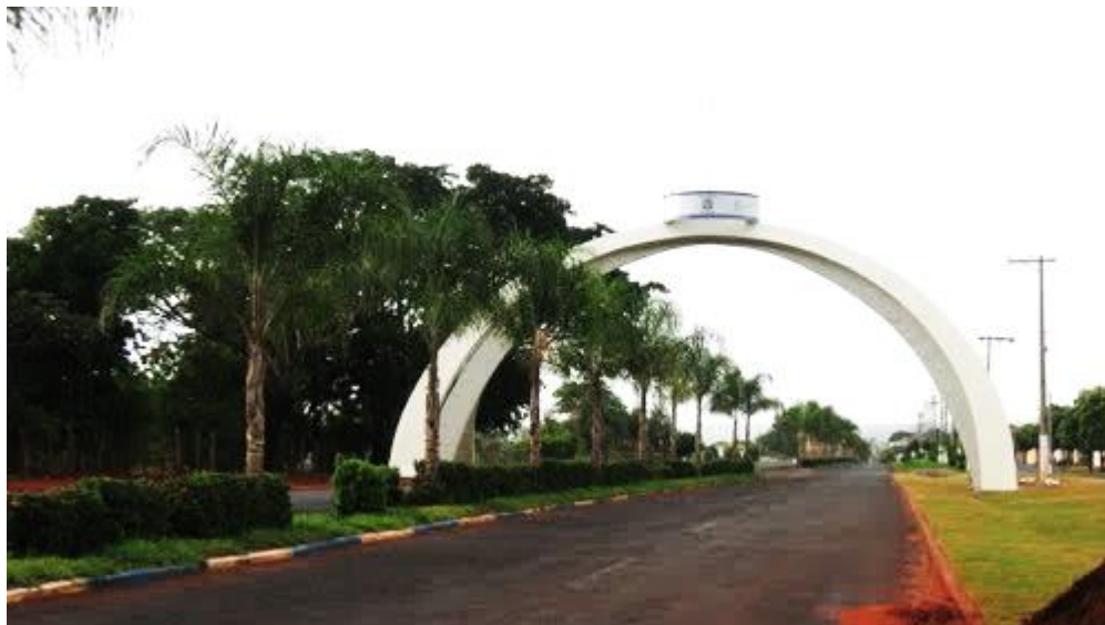
Figura 99: Portal da cidade - Fonte: PMR
