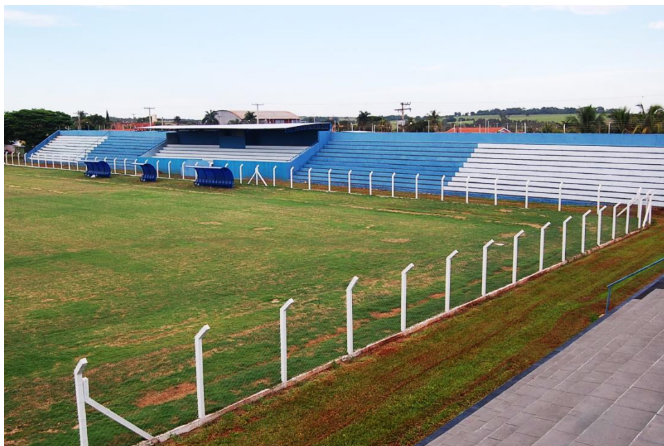
Figura 110: Campo de Futebol – Fonte PMR.
