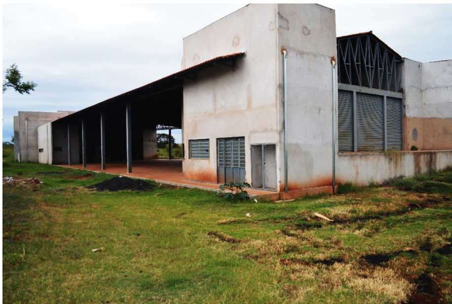
Figuras 122 e 123: Construção do Centro de Eventos – Fonte PMR.
