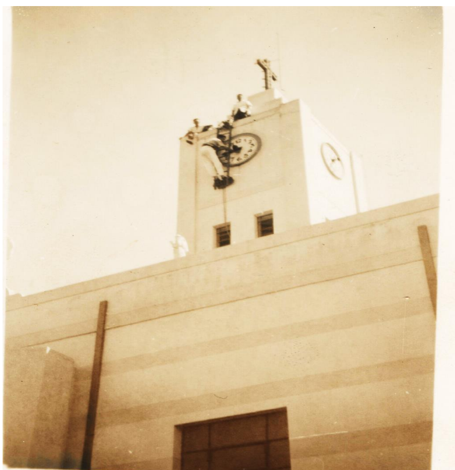
Figura 12: Instalação do Relógio da Igreja – Fonte: PMR.
