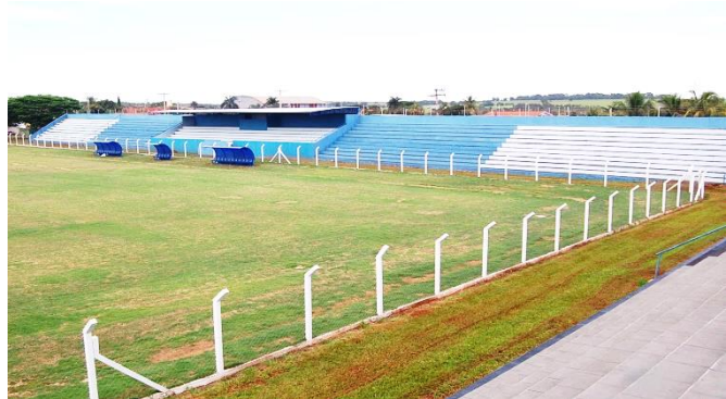
Figura 85: Campo de futebol 1 Avenida 15 entre as Ruas 18 e 20
