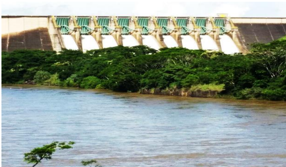
Figura 125: Abertura das comportas da UHE – Fonte UHE Marimbondo.
