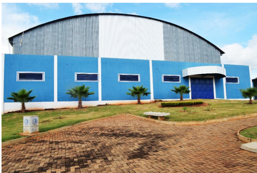
Figura 111: Ginásio de Esportes – Fonte PMR.
