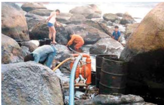
7.7. Bombeamento a vácuo de empoçamentos em costões heterogêneos. Banco de imagens da CETESB
