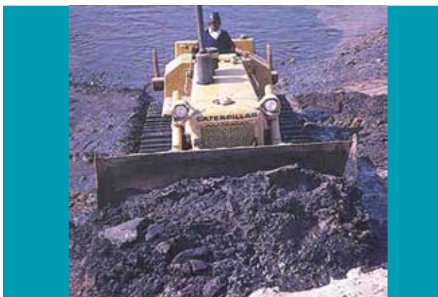
3.1. Remoção de óleo e areia com máquina em zona entremarés. Banco de imagens da CETESB
