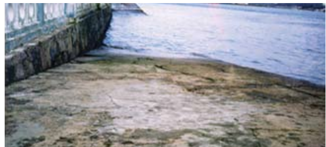
8.3. Rampa para embarcação, Santos (SP). Banco de imagens da CETESB
