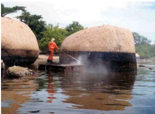
3.4. Jateamento de costões rochosos, Baía de Guanabara, RJ, 2000. Banco de imagens da CETESB
