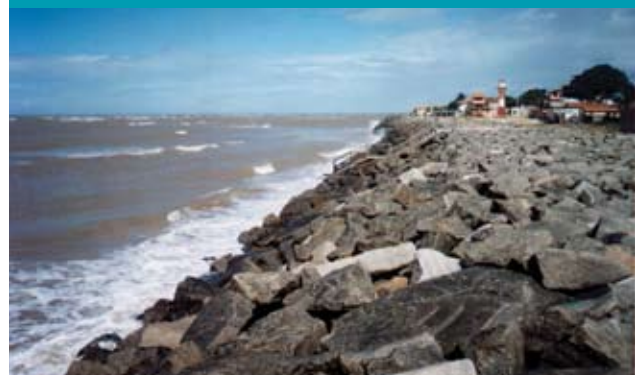
8.4. Enrocamento localizado em Conceição da Barra (ES). Lopes, Carlos Ferreira
