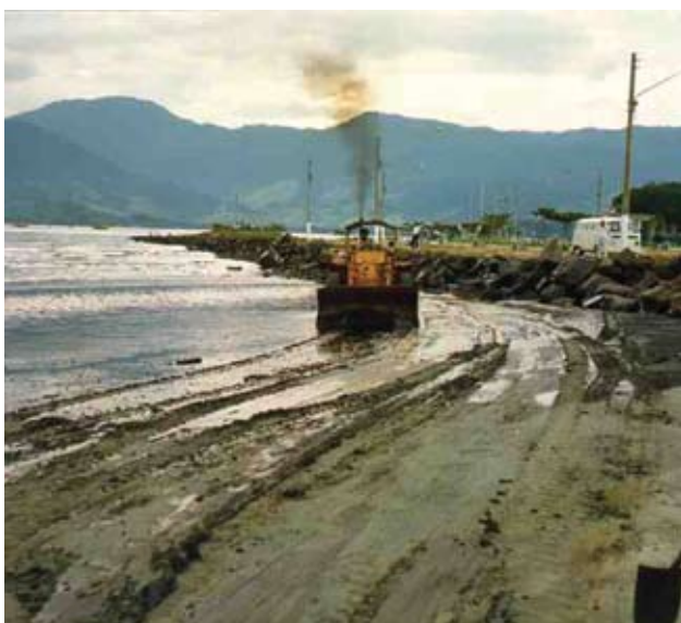
3.2. Uso de máquina pesada no vazamento Hamilton Lopes, São Sebastião, 1986. Banco de imagens da CETESB
