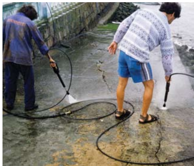
8.9. Detalhe de jateamento a alta pressão em rampa contaminada, Santos (SP). Banco de imagens da CETESB
